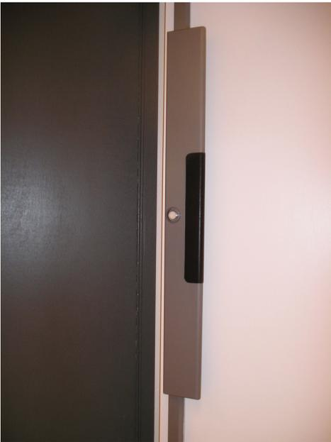
Le bouton de sortie est intégré dans la poignée, pour les portes s'ouvrant vers l'intérieur.
